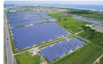
岩沼市震災復興事業 いわぬま臨空メガソーラー発電所 (28.3MW)
