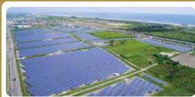
太陽光発電システム*
