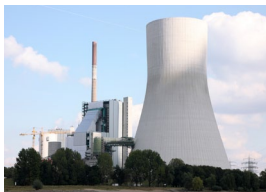
超々臨界圧石炭火力発電プラント*
