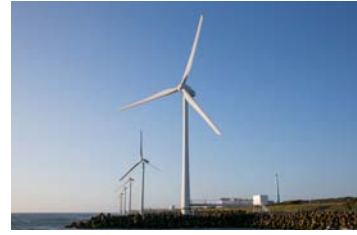
株式会社 ウィンド・パワー・いばらき ウィンド・パワーかみす第1洋上風力発電所
