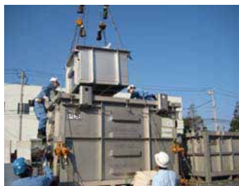
PCB廃棄物のコンテナ積込作業
