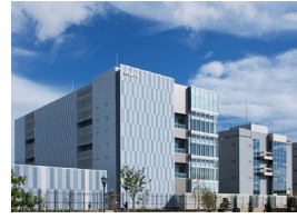
データセンタ（岡山第3センタ）*
