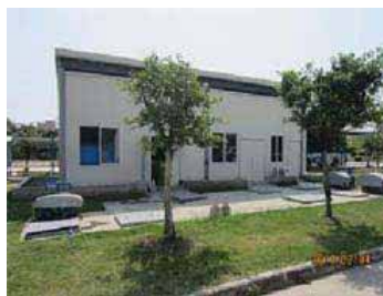
埋め立て式汚水処理センター
