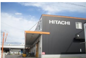
大阪生産センターの外観
