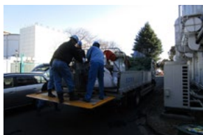
微量PCB廃棄物の搬出作業
